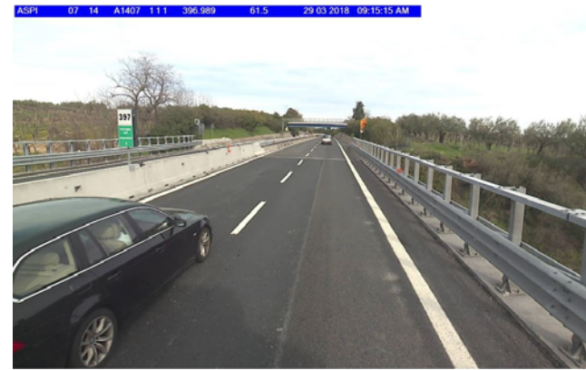
Foto 4 Carreggiata est, km 396+989
