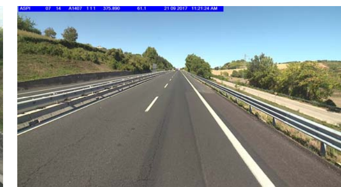
Foto 2 Carreggiata est, km 375+998
