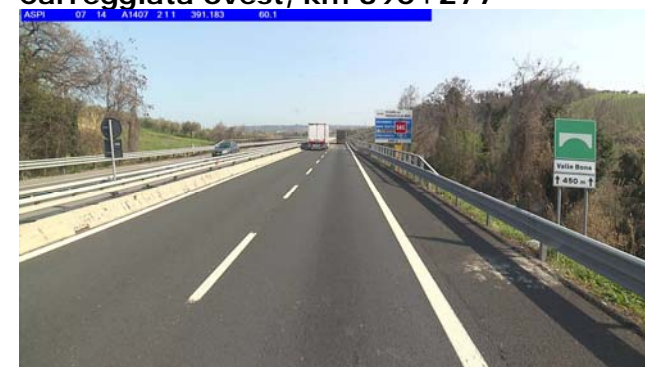
Foto 27 Carreggiata ovest, km 391+018
