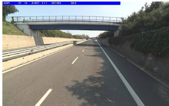
Foto 3 Carreggiata ovest, km 397+003
