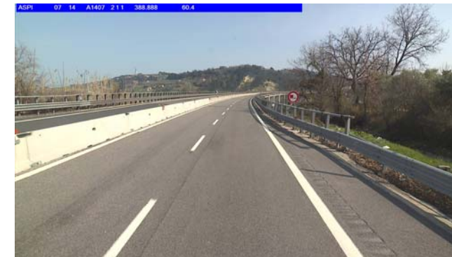
Foto 23 Carreggiata est, km 388+717
