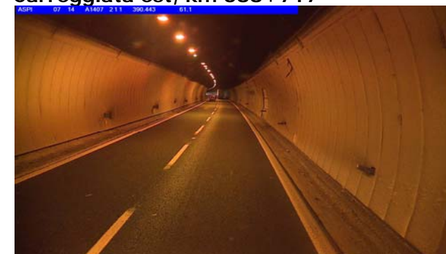
Foto 25 Carreggiata ovest, km 390+277
