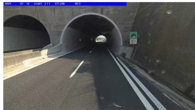
Foto 5 Carreggiata ovest, km 377+102
