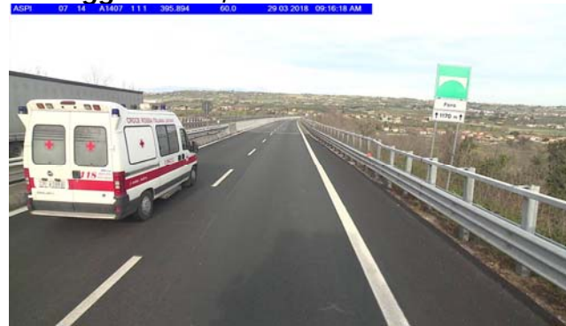
Foto 34 Carreggiata nord, km 395+923
