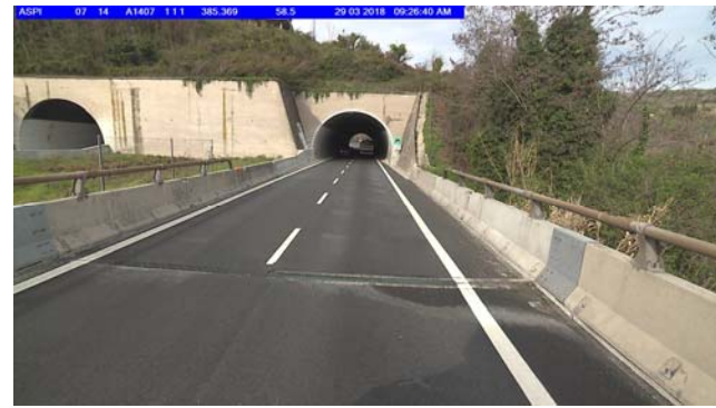
Foto 16 Carreggiata est, km 385+405
