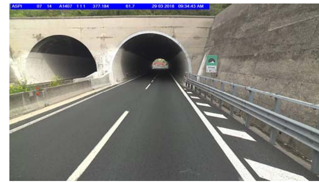
Foto 6 Carreggiata est, km 377+220
