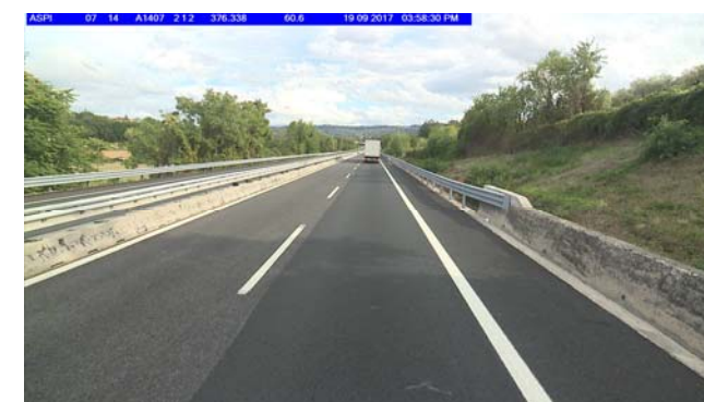
Foto 1 Carreggiata ovest, km 376+000
