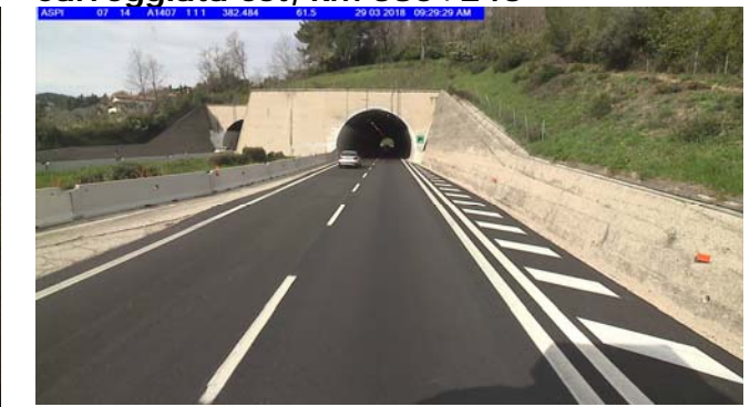
Foto 14 Carreggiata est, km 382+530
