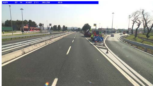
Foto 31 Carreggiata nord, km 393+093
