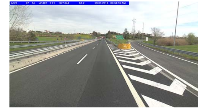
Foto 8 Carreggiata est, km 377+673
