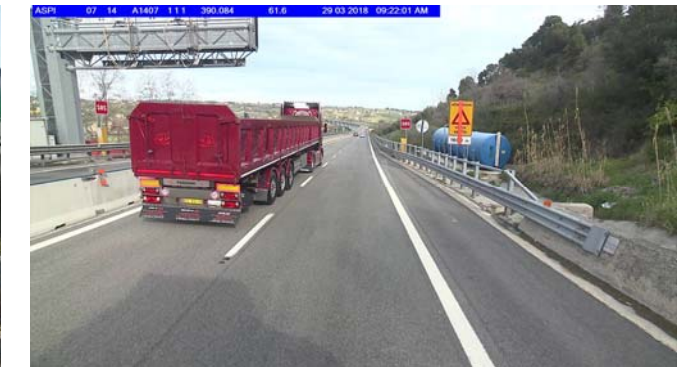
Foto 24 Carreggiata est, km 390+107
