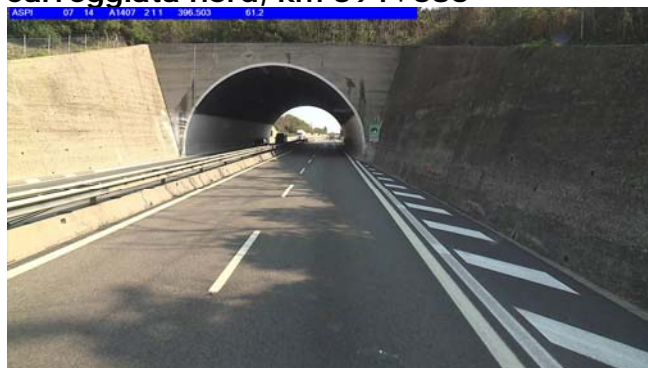
Foto 35 Carreggiata nord, km 396+332
