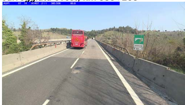
Foto 17 Carreggiata ovest, km 385+394
