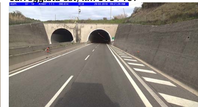
Foto 26 Carreggiata est, km 390+642
