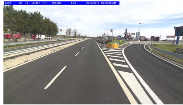
Foto 32 Carreggiata sud, km 393+223
