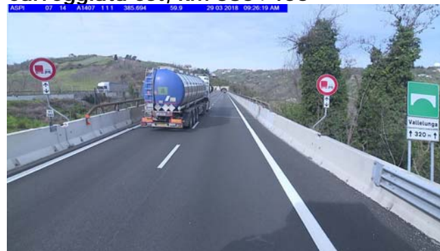
Foto 18 Carreggiata est, km 385+739
