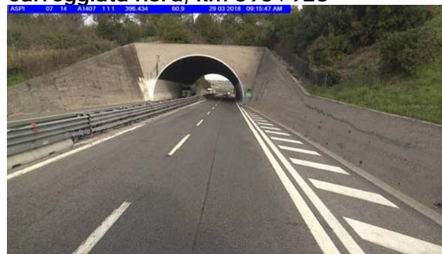
Foto 36 Carreggiata sud, km 396+459
